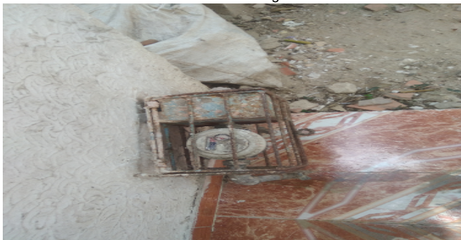
Contador de Agua
