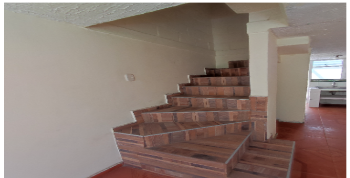
Escalera del inmueble
