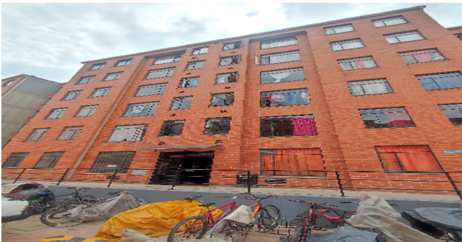
Fachada del Inmueble
