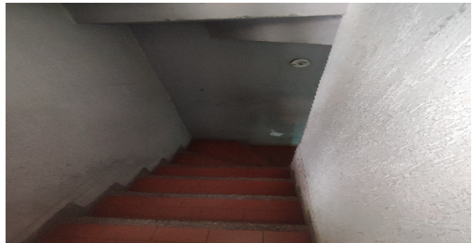
Escalera común - CJ
