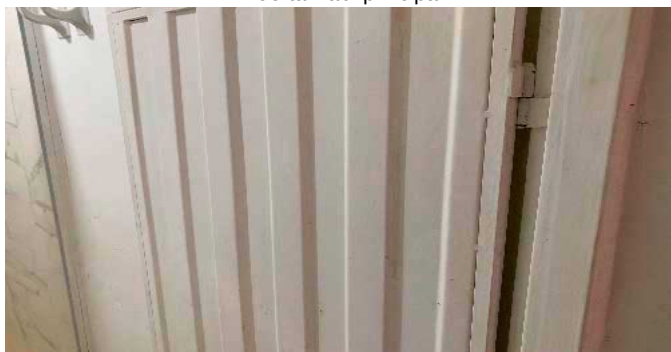
Puerta Hab. principal
