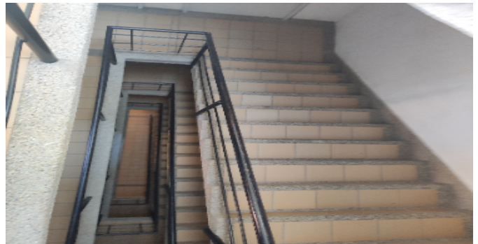
Escalera común - CJ
