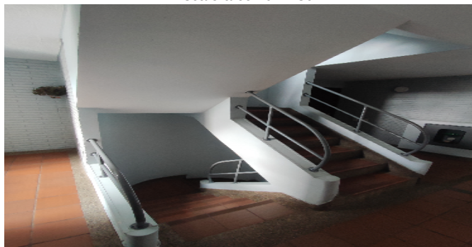
Escalera común - CJ
