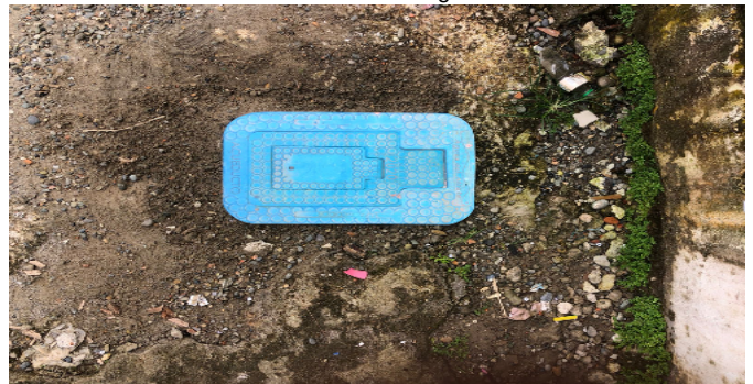
Contador de Agua
