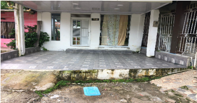
Contador de Agua
