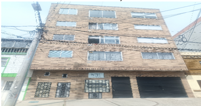
Fachada del Conjunto
