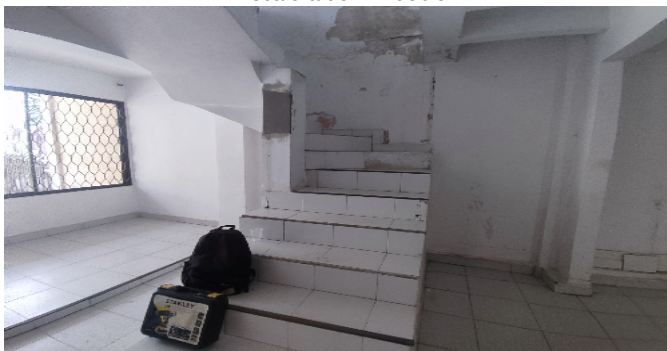
Escalera del inmueble
