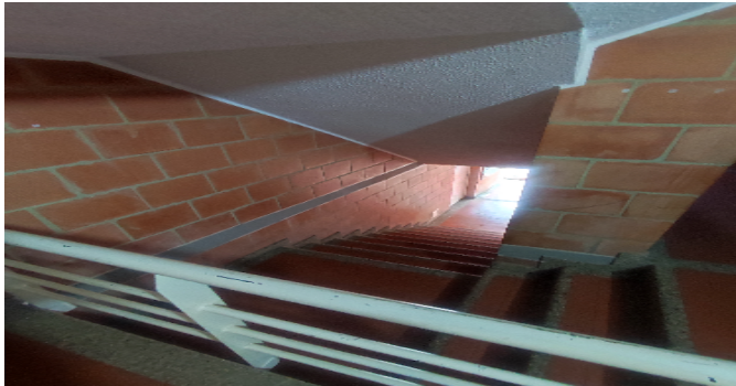
Escalera común - CJ
