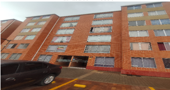
Fachada del Inmueble
