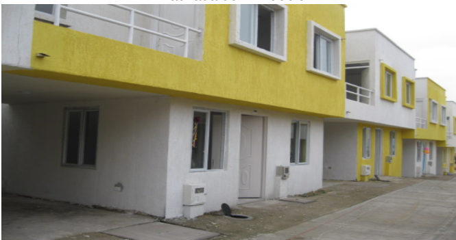
Fachada del Inmueble
