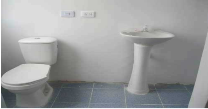
Baño Privado Hab 1
