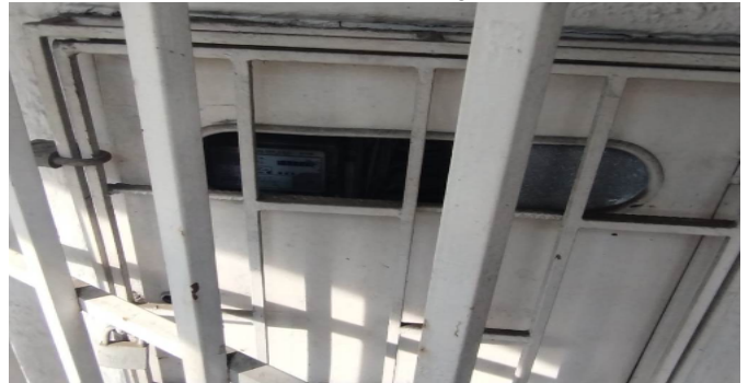
Contador de Energia
