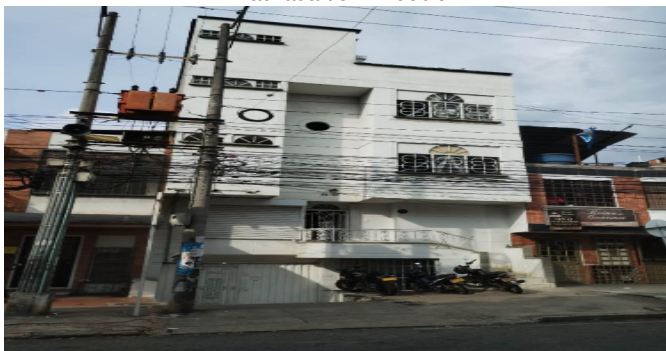
Fachada del Inmueble
