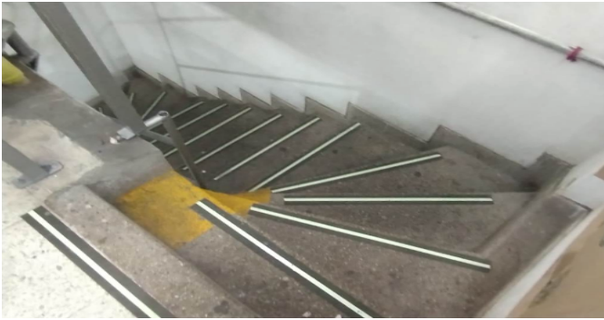
Escalera del inmueble
