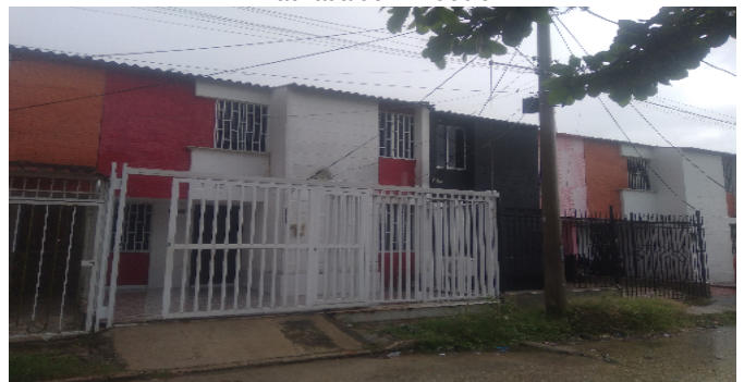
Fachada del Inmueble
