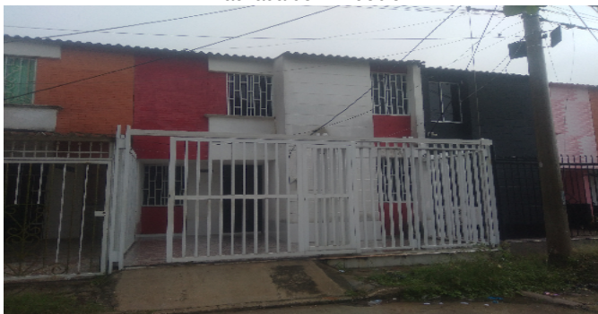
Fachada del Inmueble
