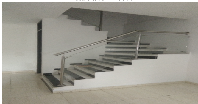
Escalera del inmueble
