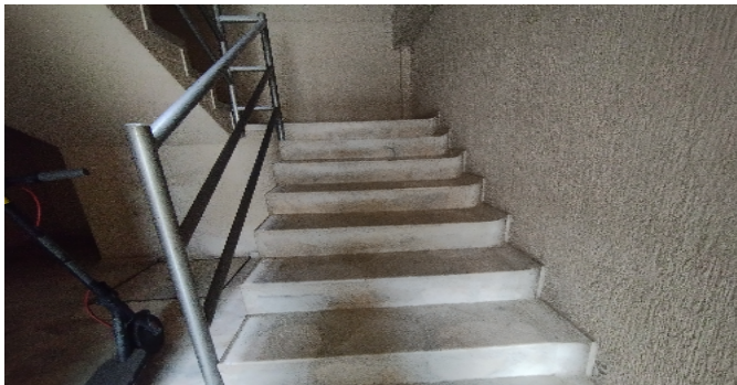
Escalera común - CJ
