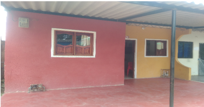
Fachada del Inmueble
