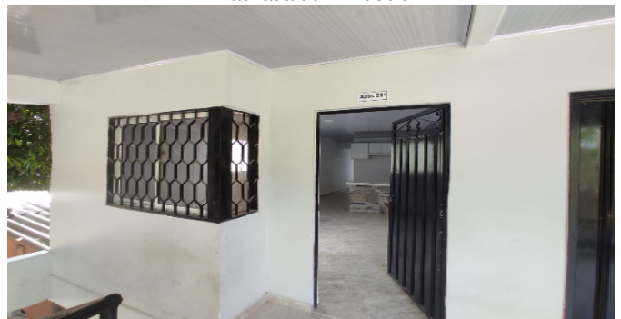
Fachada del Inmueble
