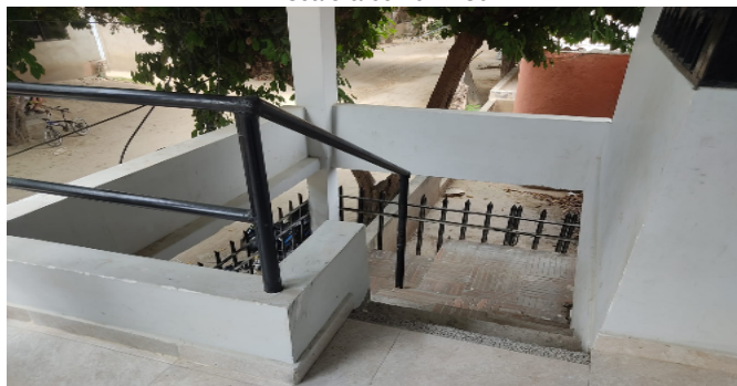
Escalera común - CJ
