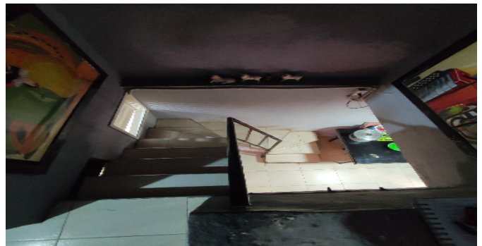
Escalera del inmueble
