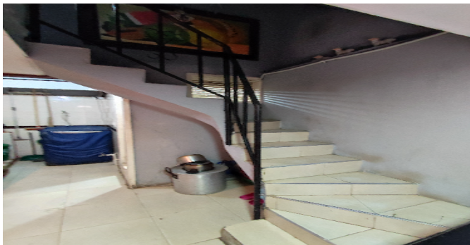
Escalera del inmueble
