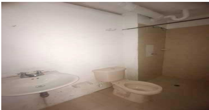
Baño Privado Hab 1
