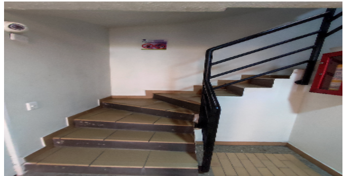
Escalera común - CJ
