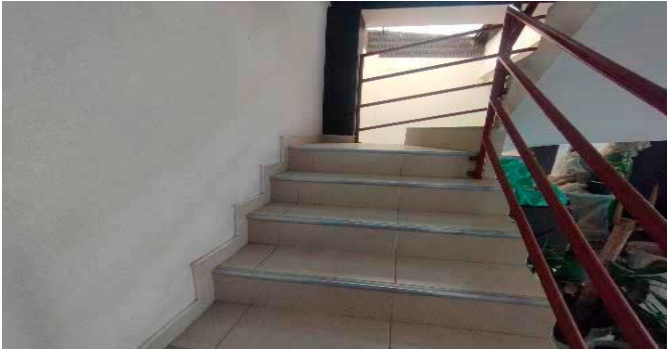
Escalera común - CJ
