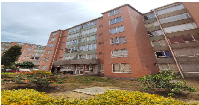
Fachada del Inmueble
