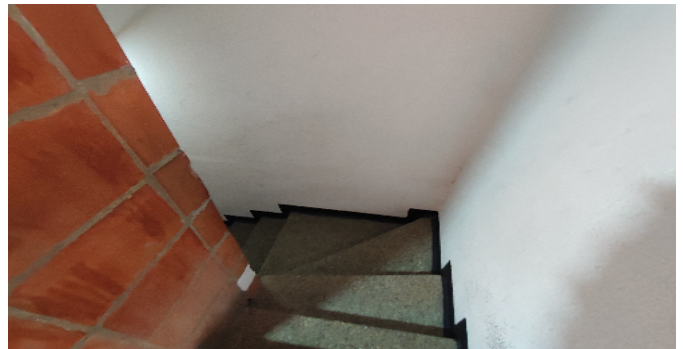
Escalera del inmueble
