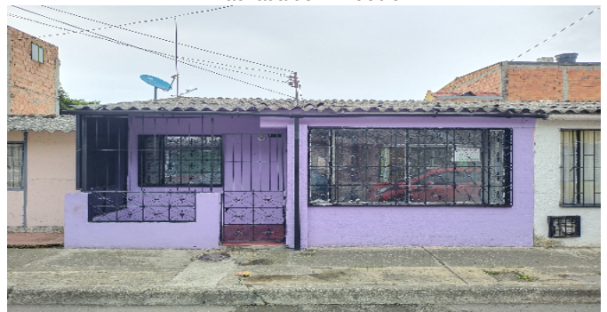
Fachada del Inmueble
