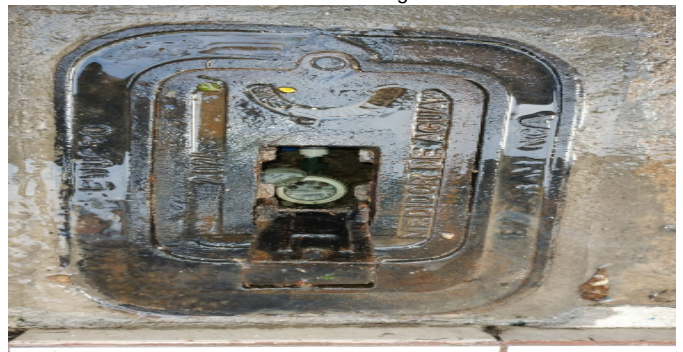
Contador de Agua
