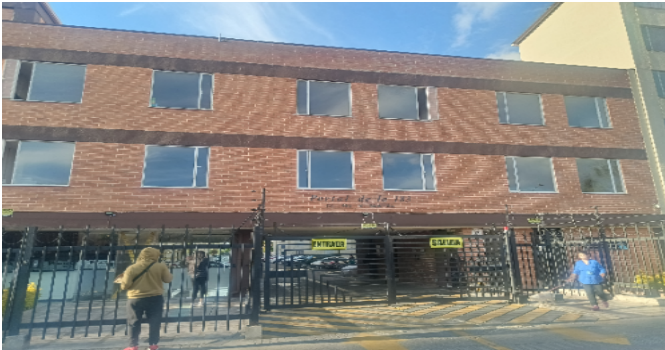
Fachada del Inmueble
