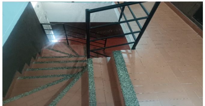
Escalera común - CJ
