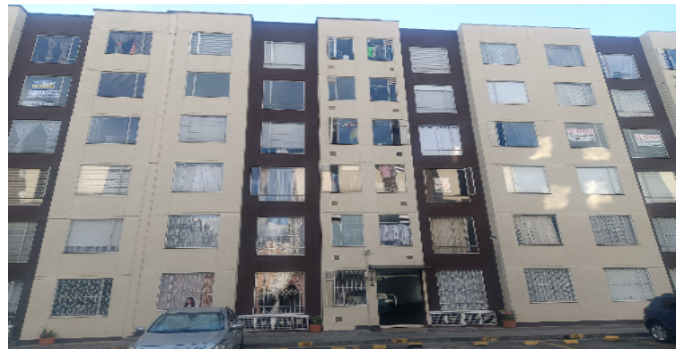
Fachada del Inmueble
