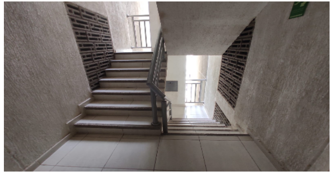
Escalera común - CJ
