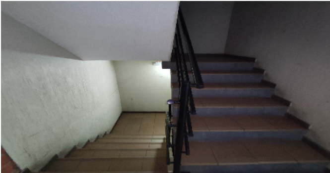
Escalera común - CJ
