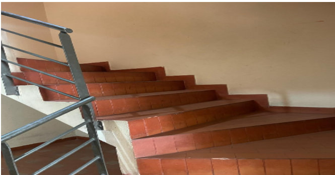
Escalera común - CJ
