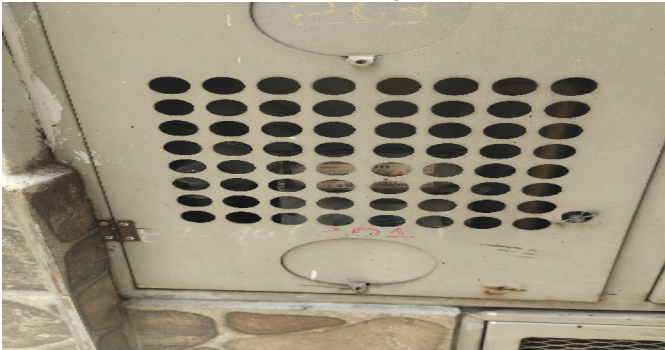
Contador de Agua
