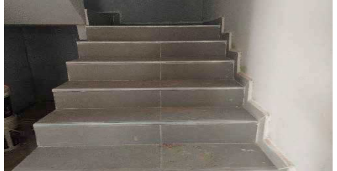
Escalera común - CJ
