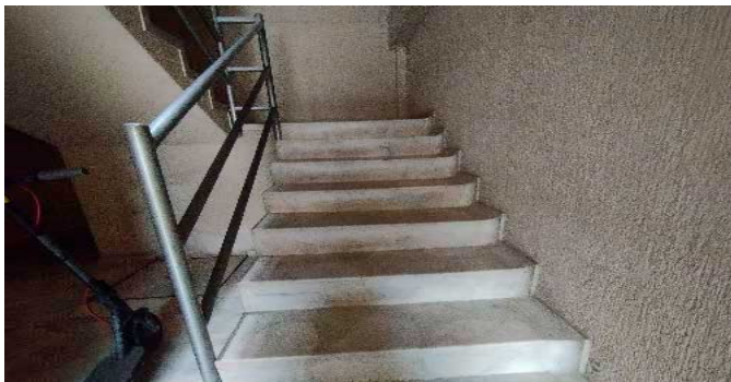
Escalera común - CJ
