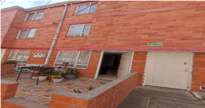
Fachada del Inmueble
