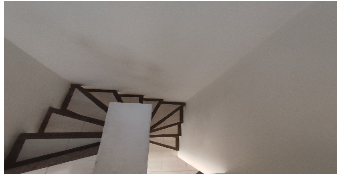
Escalera del inmueble
