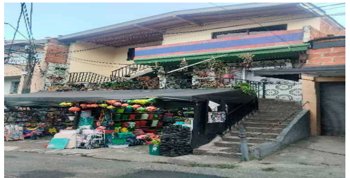
Fachada del Inmueble
