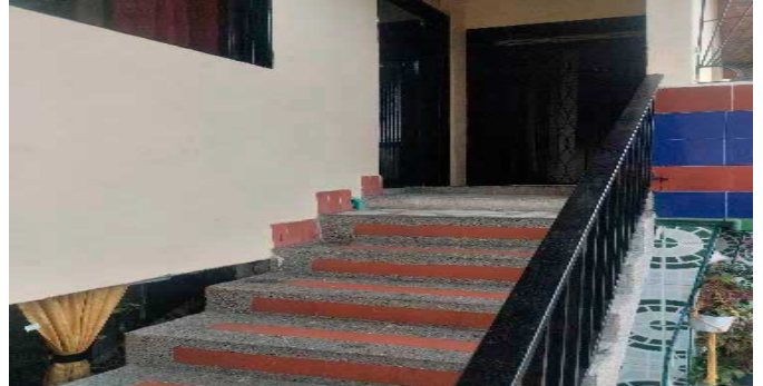
Escalera del inmueble
