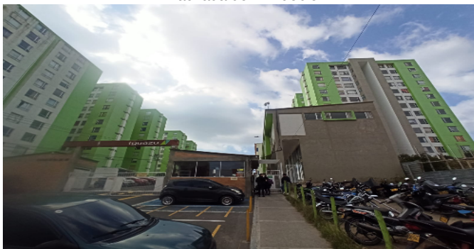
Fachada del Inmueble
