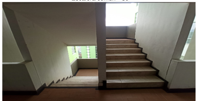
Escalera común - CJ
