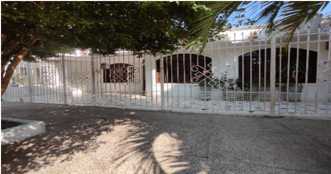
Fachada del Inmueble
