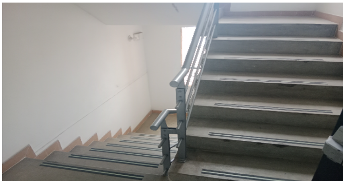
Escalera común - CJ
