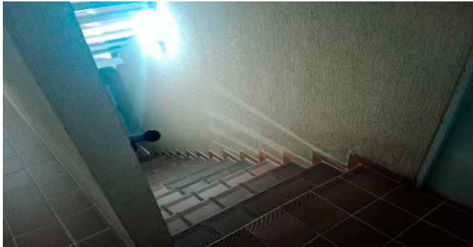
Escalera común - CJ
