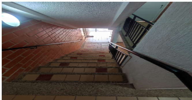
Escalera común - CJ
