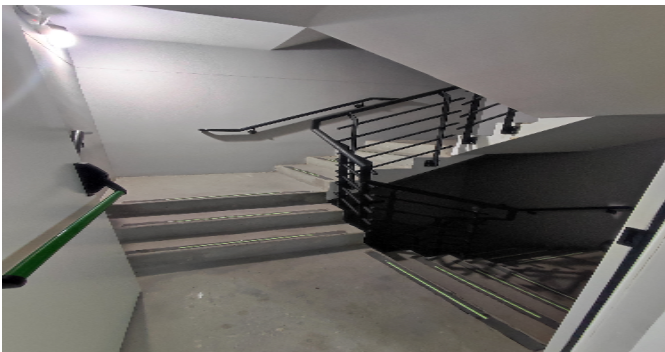
Escalera común - CJ
