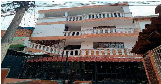
Fachada del Inmueble
