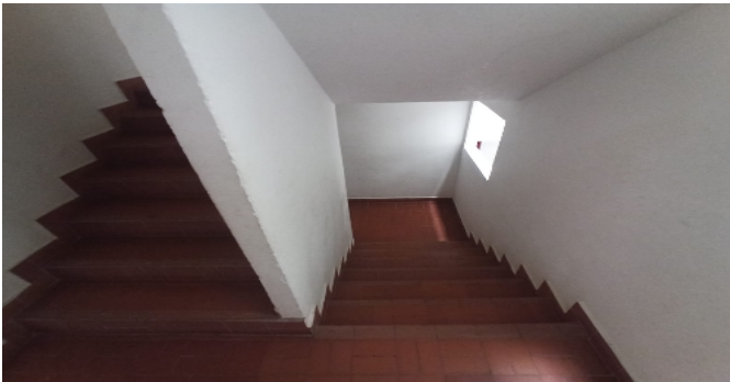
Escalera común - CJ
