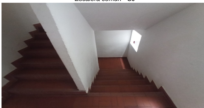
Escalera común - CJ
