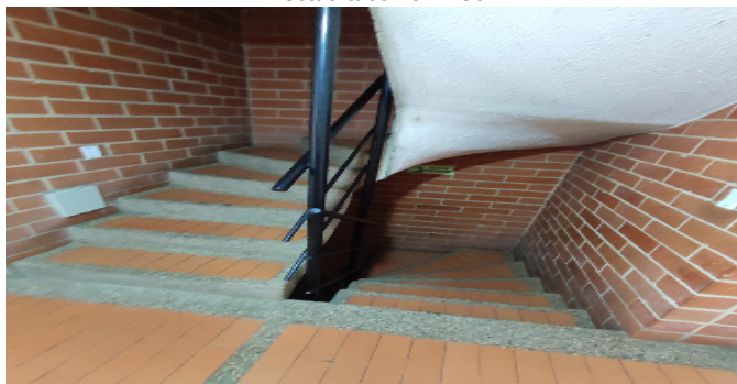
Escalera común - CJ
