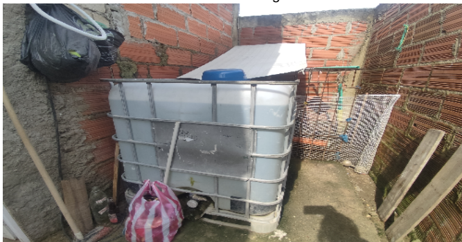
Contador de Agua
