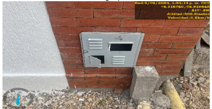
acometida de gas por instalar
