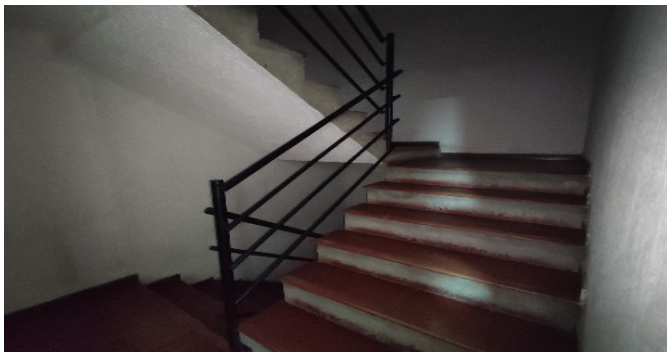
Escalera común - CJ
