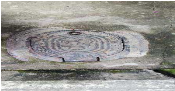
Contador de Agua
