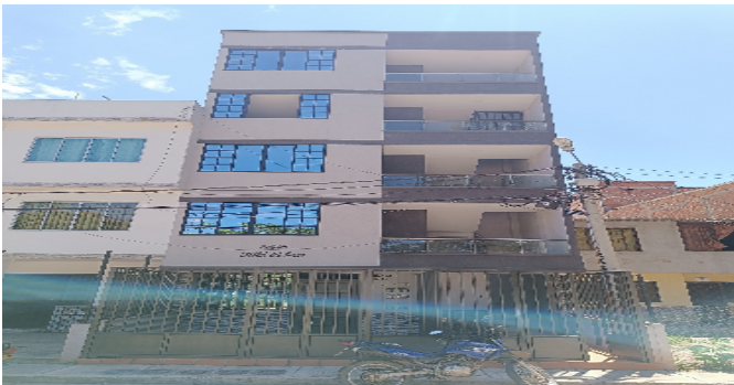
Fachada del Inmueble
