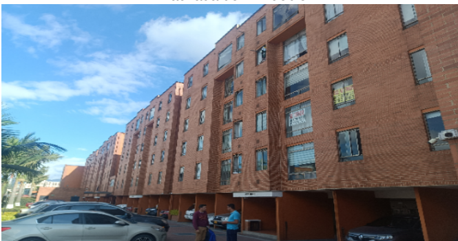
Fachada del Inmueble
