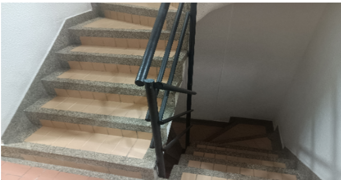
Escalera común - CJ
