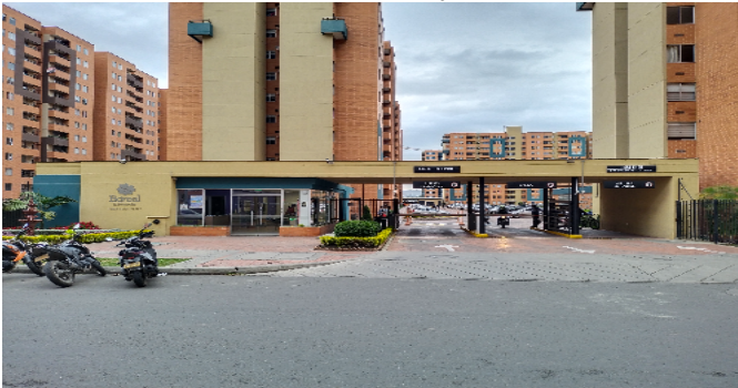
Fachada del Conjunto
