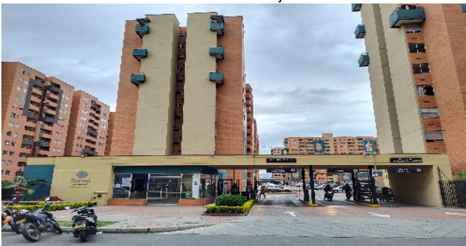
Fachada del Conjunto
